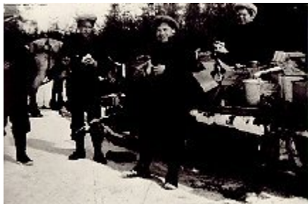
hommes au chantier, sur l'heure du diner
