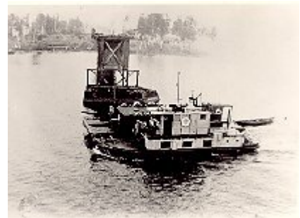
Construction du Grassy-Narrow
